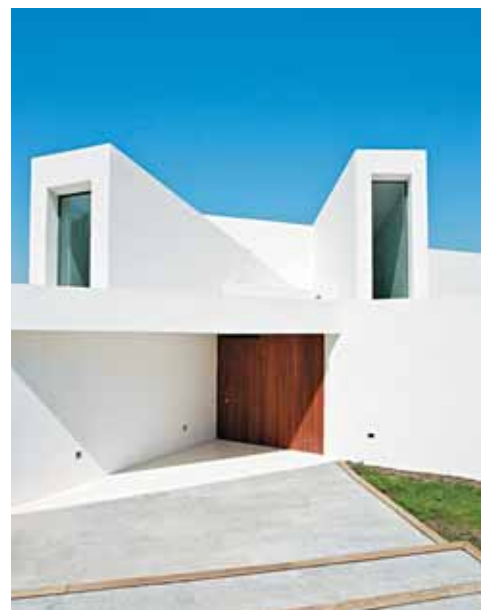
Vista NE del acceso principal.
