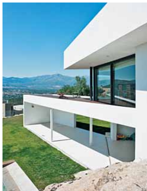
Vista del porche jardín en planta semisótano.
