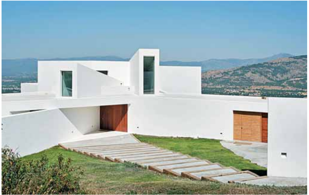
Vista general NE.
